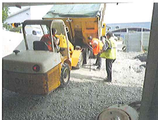
Livraison du bitume
