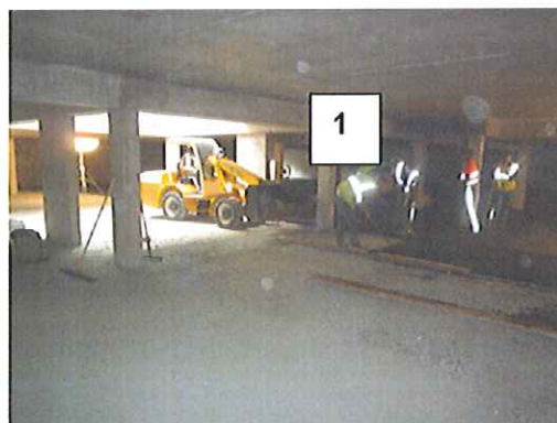
Dépose du bitume
